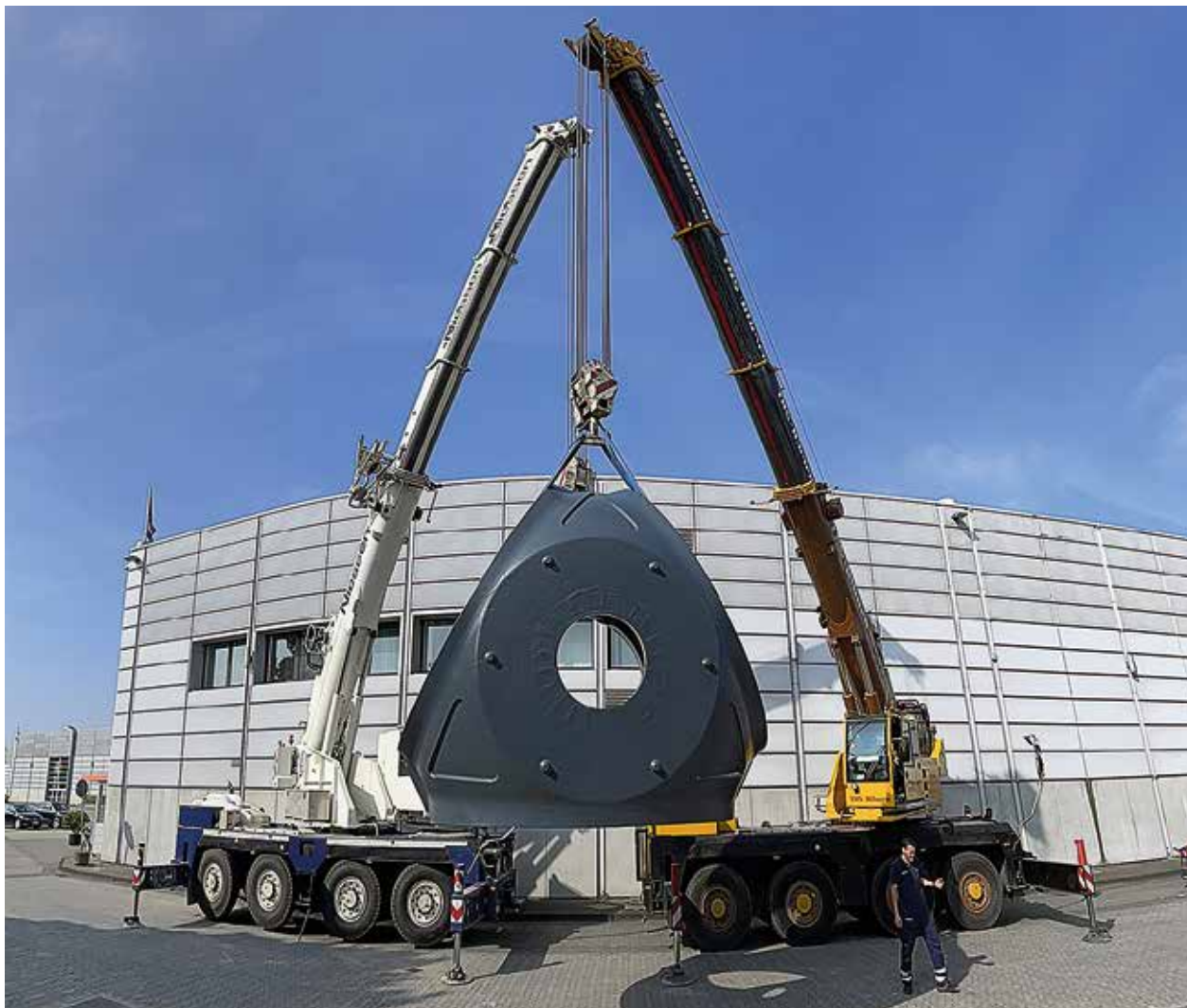
Die 34-Tonnen-Nabe einer Windenergie-Anlage für den BDG-Messestand wird vor Halle 13 angeliefert.
